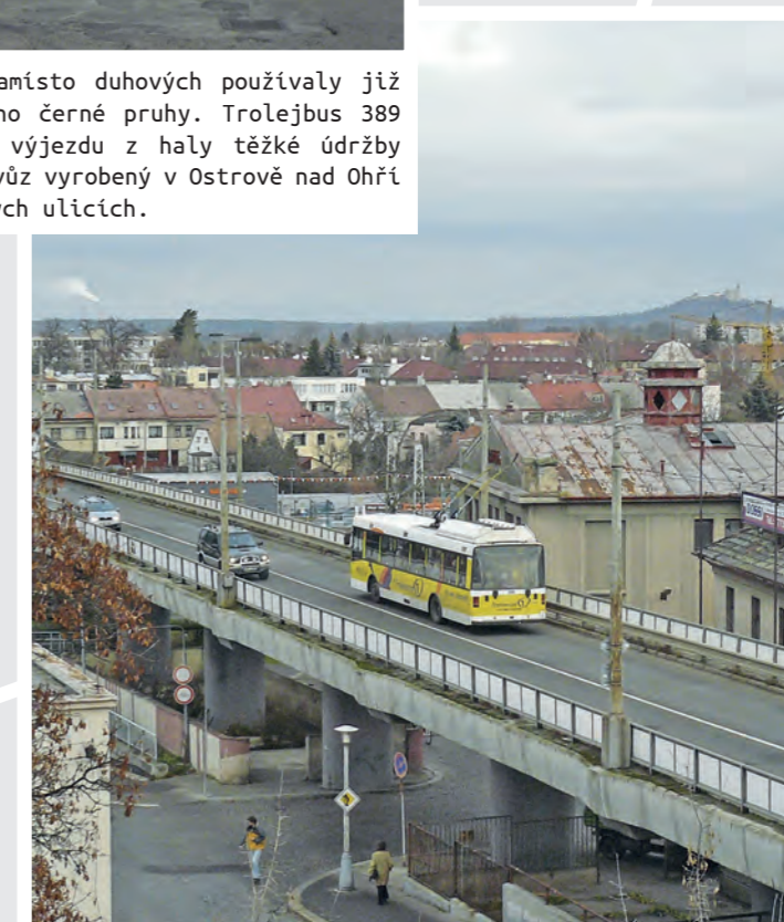
Stavba nadjezdu do Pardubiček byla zahájena v roce 1961. O 50 let později pak pracovník DPMP, který byl právě na povinné lékařské prohlídce, vyfotografoval z okna nemocnice na této mostní konstrukci trolejbus 390.
